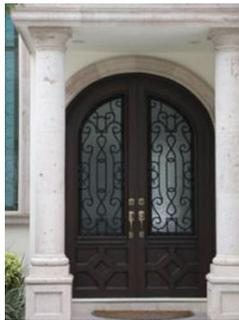
**3.- Columna o pilastra:** es un pilar utilizado en la construcción. Sirve para soportar el peso de toda la estructura, sosteniendo techo, tejado, entablamento, etc. Puede tener elementos decorativos. Contiene los siguientes componentes:
